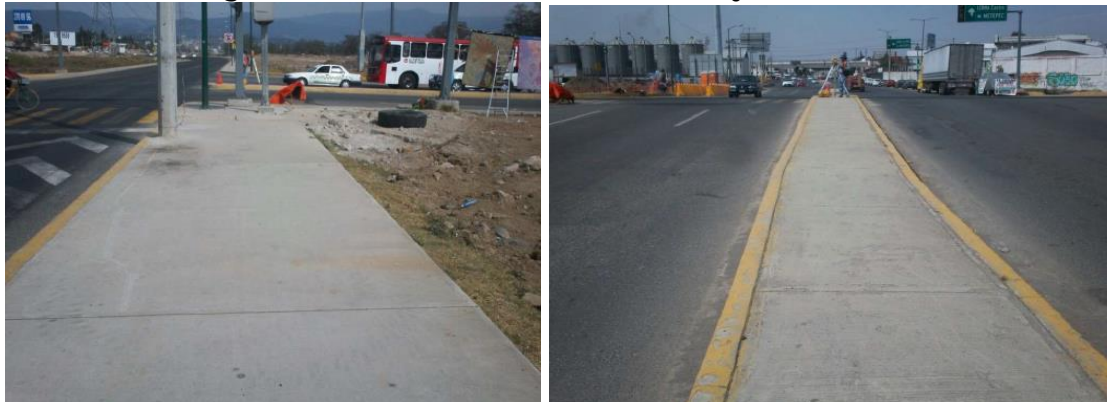
Fotografía 3 Intersección Av. Las Torres y Av. Benito Juárez.
