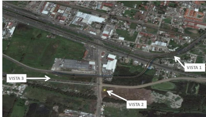
Ilustración 18 Estructura operativa inicial y fin del viaducto
