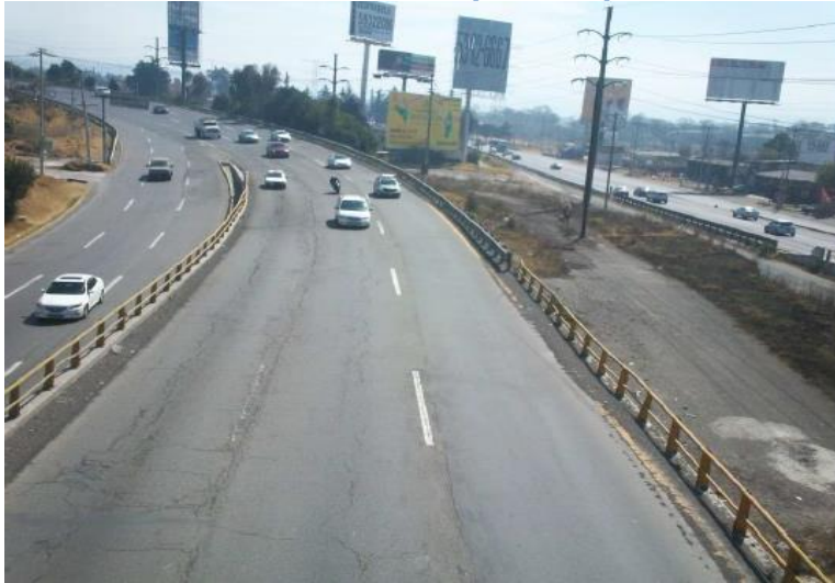
Fotografía 7 Cruce del eje 30, por el cuerpo a de la autopista México-Toluca, vista desde el puente peatonal
