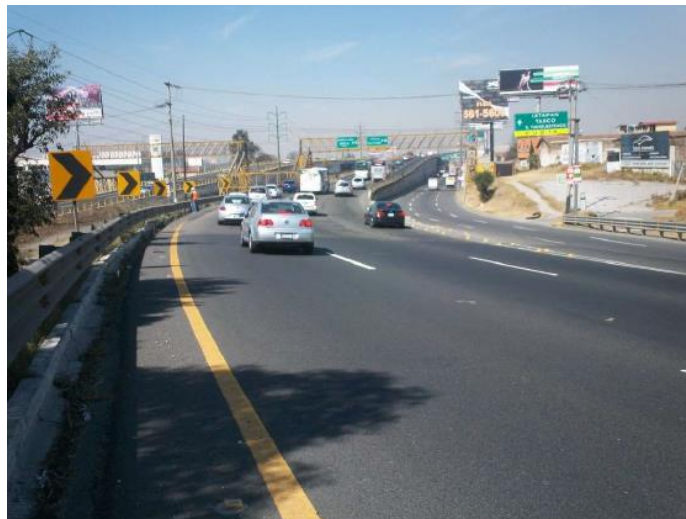
Fotografía 5 Carretera México – Toluca, Cuerpo A, vista hacia Toluca, cruce con Benito Juárez García
