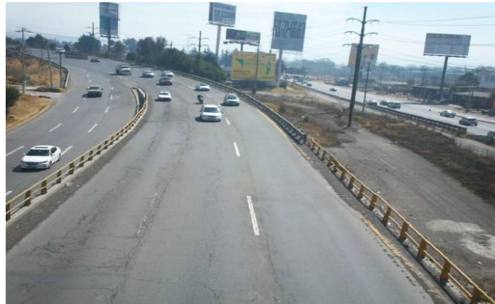
Fotografía 6 Carretera México – Toluca, cuerpo A, vista hacia México, cruce con Benito Juárez García
